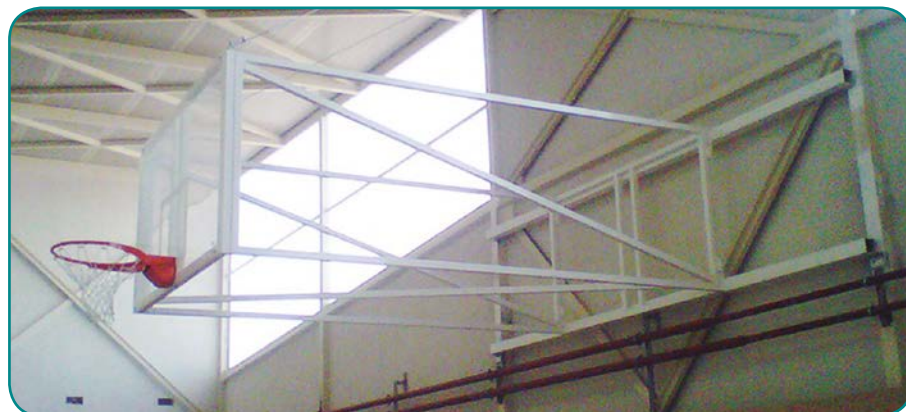
◀ Canasta de 2,5 m entre cerchas mediante estructura metálica soldada y cable tirante de sujeción
