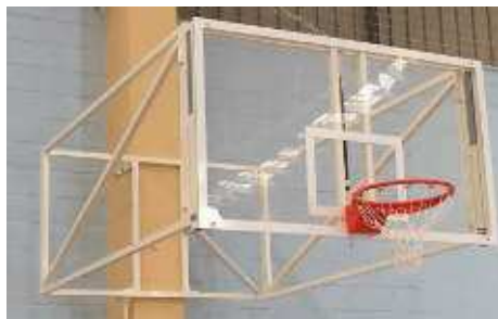
Cistella de 2,5 m de vol subjecta a columna mitjançant suport metàl·lic i cable tirant.
