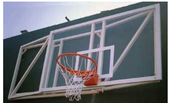
Cistella de 1 m fixada directament a paret de formigó en posició d'abatut.
